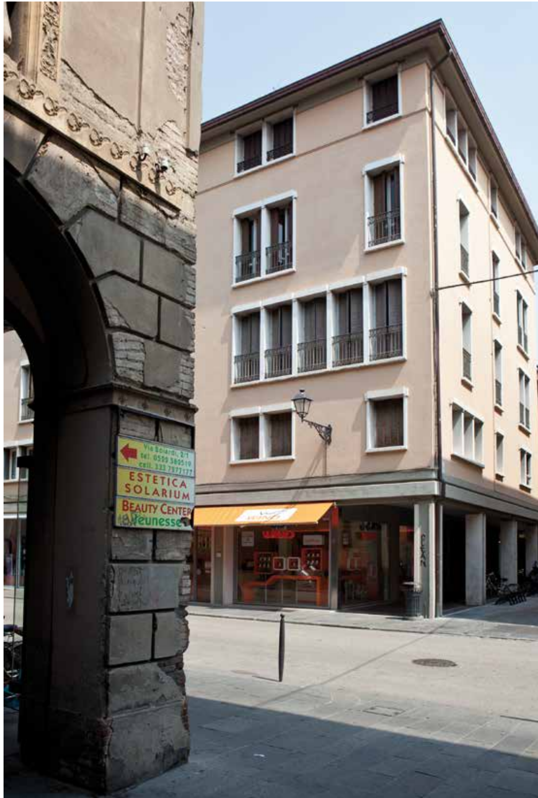
Condominio in via dell'Abbadessa
