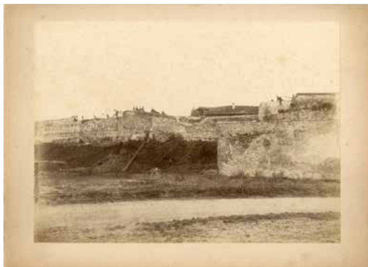
Dalla mostra documentaria su Claudio Fossa, la fotografia all'albmina di G. Fantuzzi, Demolizione delle mura di Reggio Emilia , 1885 ca.
